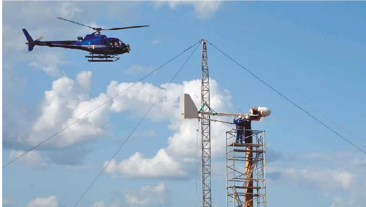
A Mozia, l'isola dello Stagnone, Terna Rete Italia ha rimosso le pale eoliche montate nell'84
