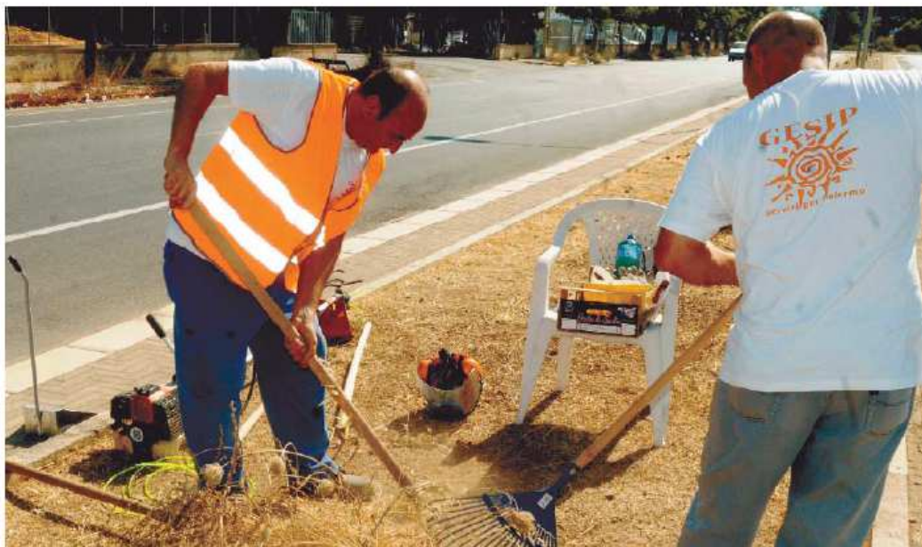
Operai della Gesip al lavoro sulle strade della città
