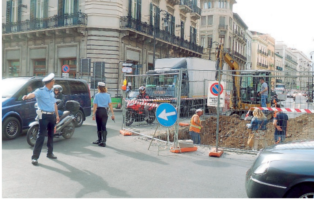
Un cantiere a Palermo, grazie alle nuove tecnologie sia gli scavi che le trincee saranno ridotti
