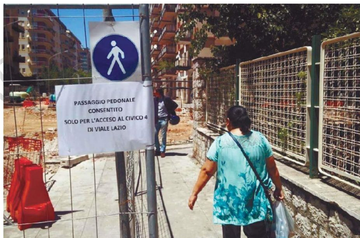
Il tratto di viale Lazio dove sorgerà una delle stazioni dell'anello ferroviario
