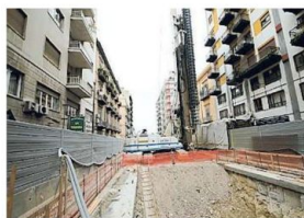
Il cantiere dell'anello ferroviario
